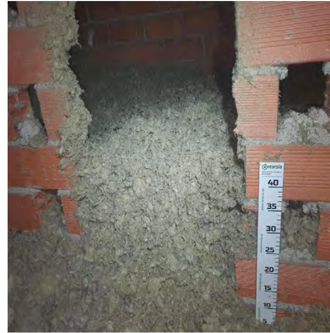
Soplat entre envans conillers sota coberta
